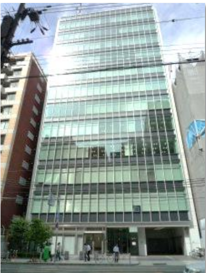
※巡回していただくビルの一例「大阪U2ビル」
